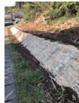
市道への土砂流入防止 【竹袋】
