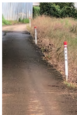
路肩注意ポールの設置 【草深】
