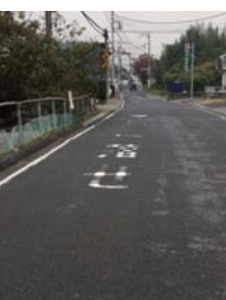
道路標示(1地点・2力所)の塗り替え
