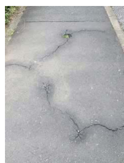
歩道の補修 【小林駅付近歩道】
