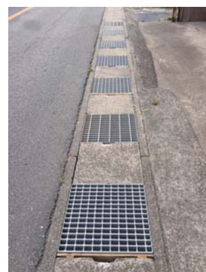
「雨水が道路沿いの家の敷地等に流れ込み困っている」との声⇒千葉県印旛土木の職員と現地調査。側溝の堆積物の除去清掃の実施、コンクリート蓋をグレーチングに変更（2地点） 【小林】
