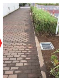
歩道の冠水→排水溝の設置等 【小林中学校横】
