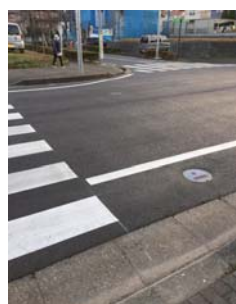
振動対策車道修繕 【すずかけ通り】
