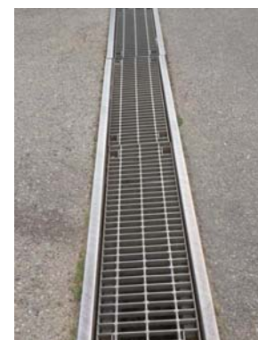
側溝の高圧洗浄 【亀成】
