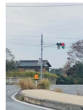
千葉ニュータウン北環状線 右折信号を増設 【鹿黒南】
