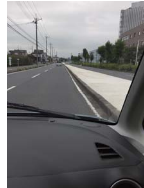
中央分離帯 コンクリート化 【大塚】
