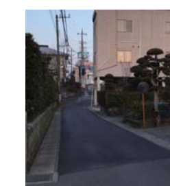
道路舗装の打ち換え【木下】
