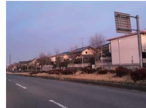
木刈6丁目沿いの歩道に防犯灯増設
