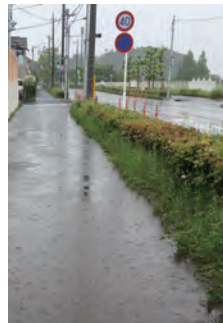
【小林中学校横】 歩道の冠水→排水溝の設置等
