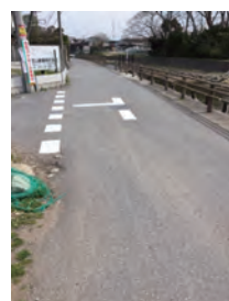
道路標示を新設
