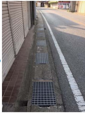
〈小林〉 「雨水が道路沿いの家の敷地等に流れ込み困っている」との声⇒千葉県印旛土木の職員と現地調査。側溝の堆積物の除去清掃の実施、コンクリート蓋をグレーチングに変更 (2 地点)
