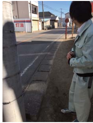
〈小林〉 「雨水が道路沿いの家の敷地等に流れ込み困っている」との声⇒千葉県印旛土木の職員と現地調査。側溝の堆積物の除去清掃の実施、コンクリート蓋をグレーチングに変更 (2 地点)
