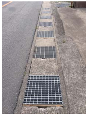
〈小林〉 「雨水が道路沿いの家の敷地等に流れ込み困っている」との声⇒千葉県印旛土木の職員と現地調査。側溝の堆積物の除去清掃の実施、コンクリート蓋をグレーチングに変更 (2 地点)
